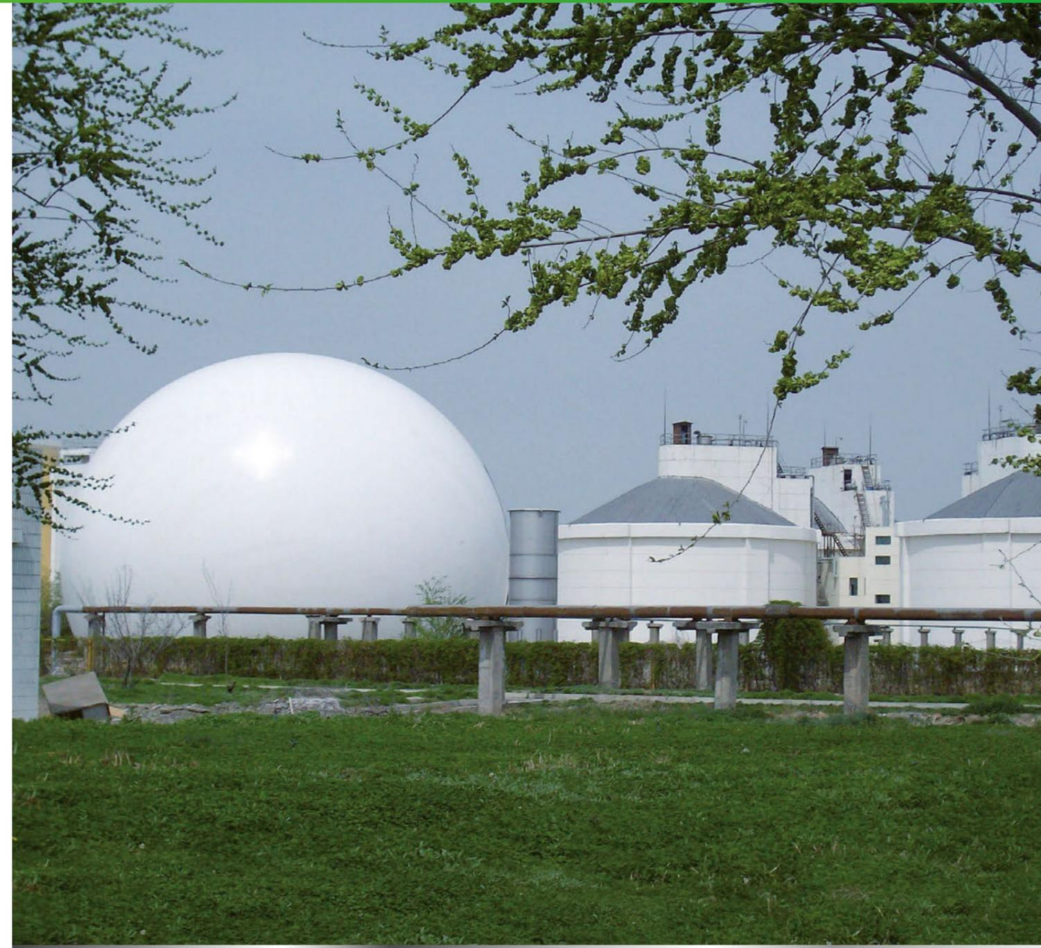
Los gasómetros de doble membrana de TECON, se instalan sobre una bancada de hormigón. Están formados por una membrana exterior, una membrana interior, y una membrana de fondo. El almacenamiento de Biogás, se realiza entre las membranas interior y de fondo.
